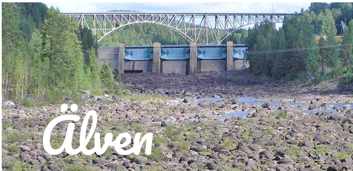
Torråra, Forsmo kraftverk Ångermanälven.
