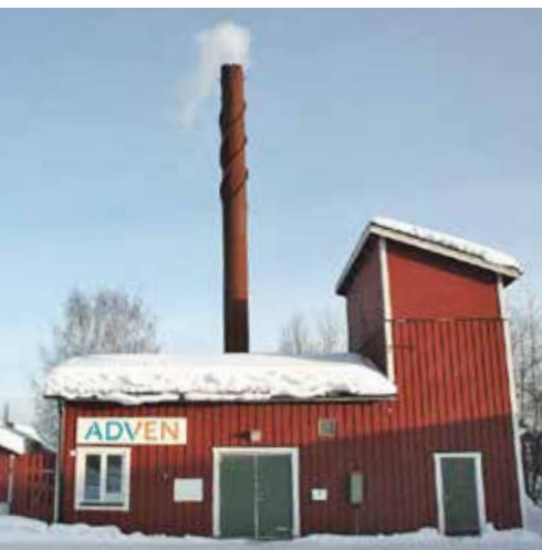
Fjärrvärmeanläggningen i Näsåker förser 11 större och 1 mindre fastighet med värme via ett kulvertsystem på 650 meter.
