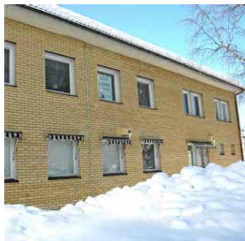
I den före detta tandläkarmottagningen på Kläppvägen finns också tomma lokaler.
