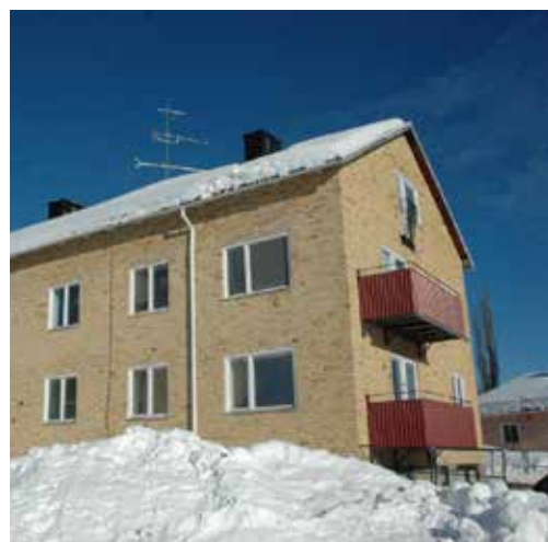
Lägenheterna i kommunens hyreshus på Orrvägen 4 kan komma att frigöras för den öppna marknaden inom kort, men först måste de renoveras.
