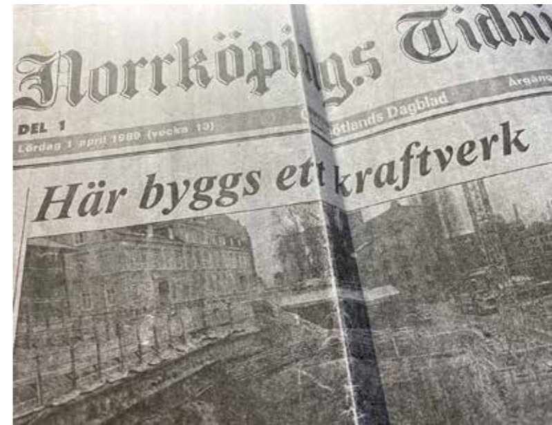
1988 är Martin Edberg med (platschef) och bygger Holmens kraftverk i Norrköping.
