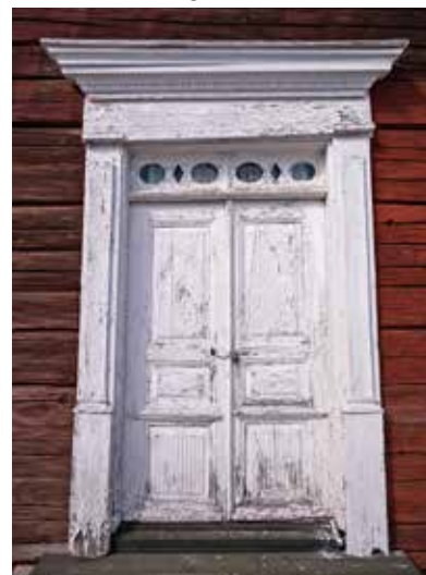
Dörrar så som de såg ut innan arbetets start.
