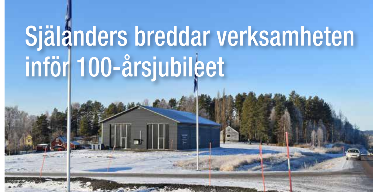
I den nya byggnaden på 450 kvadratmeter kommer Själanders att bygga moduler till monteringsfärdiga hus.
