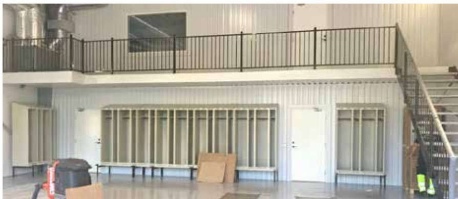
Bakom det stora garaget finns väl anpassade utrymmen för omklädnings, träning och administration.
