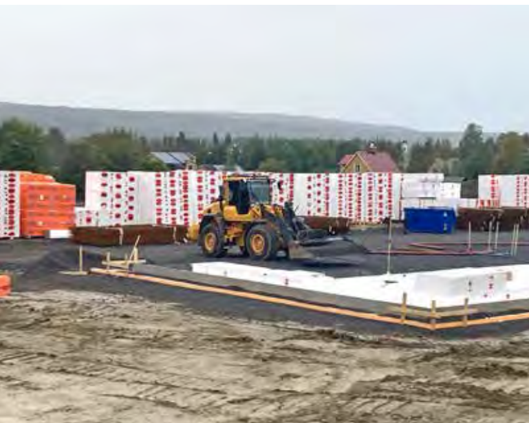
Här bygger Själanders Åkeri ett nytt stort industrihus med plats för många olika verksamheter. Förberedelserna för bottenplattan är redan i full gång.
