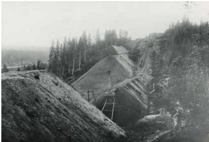
Järnvägsbanken vid ca 32 km av Forsmo- Hotingbanan. Foto från Digitalmuseum.
