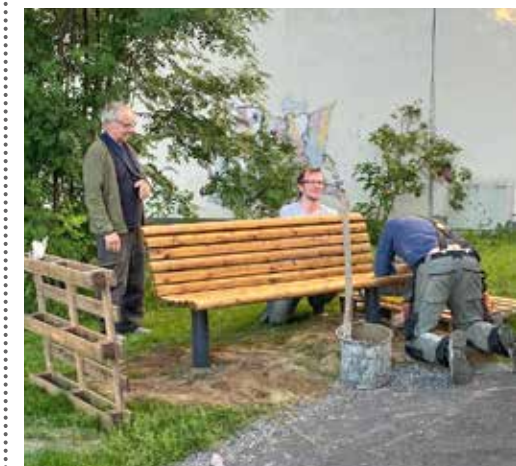
Kent Lidström, Arvid och Torsten Berglund i färd med att montera en bänk vid Centrumhuset.
