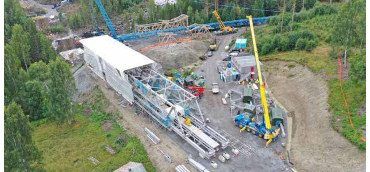
Just nu är den gamla bron riven och nerlyft från järnvägen, till höger i bilden. Under tak på banvallen monteras och målas nu den nya bron, som senare i höst ska skjutas på plats där den gamla stod. Foto: Sara Storgård.
