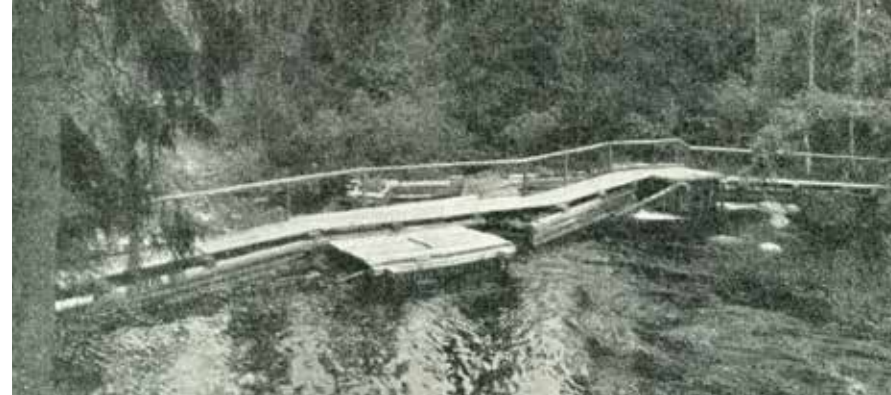
Den mellersta anläggningen i Laxbäcken med de båda laxkaren, sedda bakifrån. Ingångarna vetter framåt. Anläggningen med stenkistor tvärs över bäckfåran gör att vattnet har väg endast genom laxkaren och därför verkar uppdämt i förgrunden. Foto Ingall Granlund 1949. Ur boken Något om laxfisket i Lidsforsen, John Granlund.
