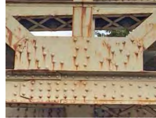
Tusentals stora nitar håller samman brons järnkonstruktion. Enligt uppgift tillverkades nitarna på plats i en särskilt uppförd smedja.
