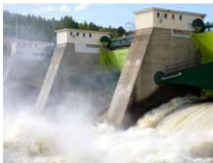
Nämforsens kraftverk, Näsåker.
